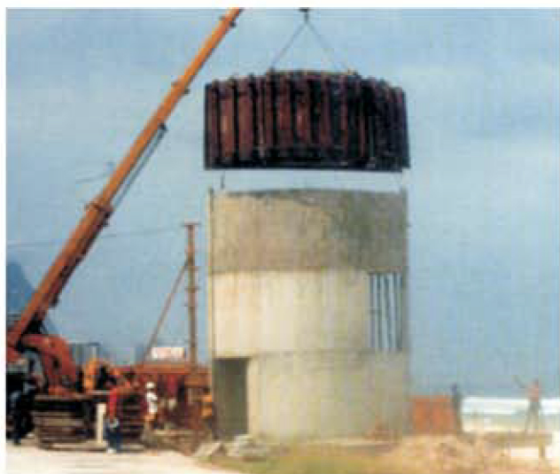
Obra: Rio Orla - RJ Construtora FERCON
