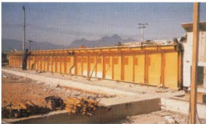
Obra: Linha Vermelha - RJ Construtora Carioca Engenharia
