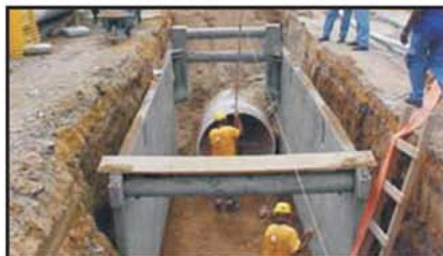
Assentamento de galeria.
